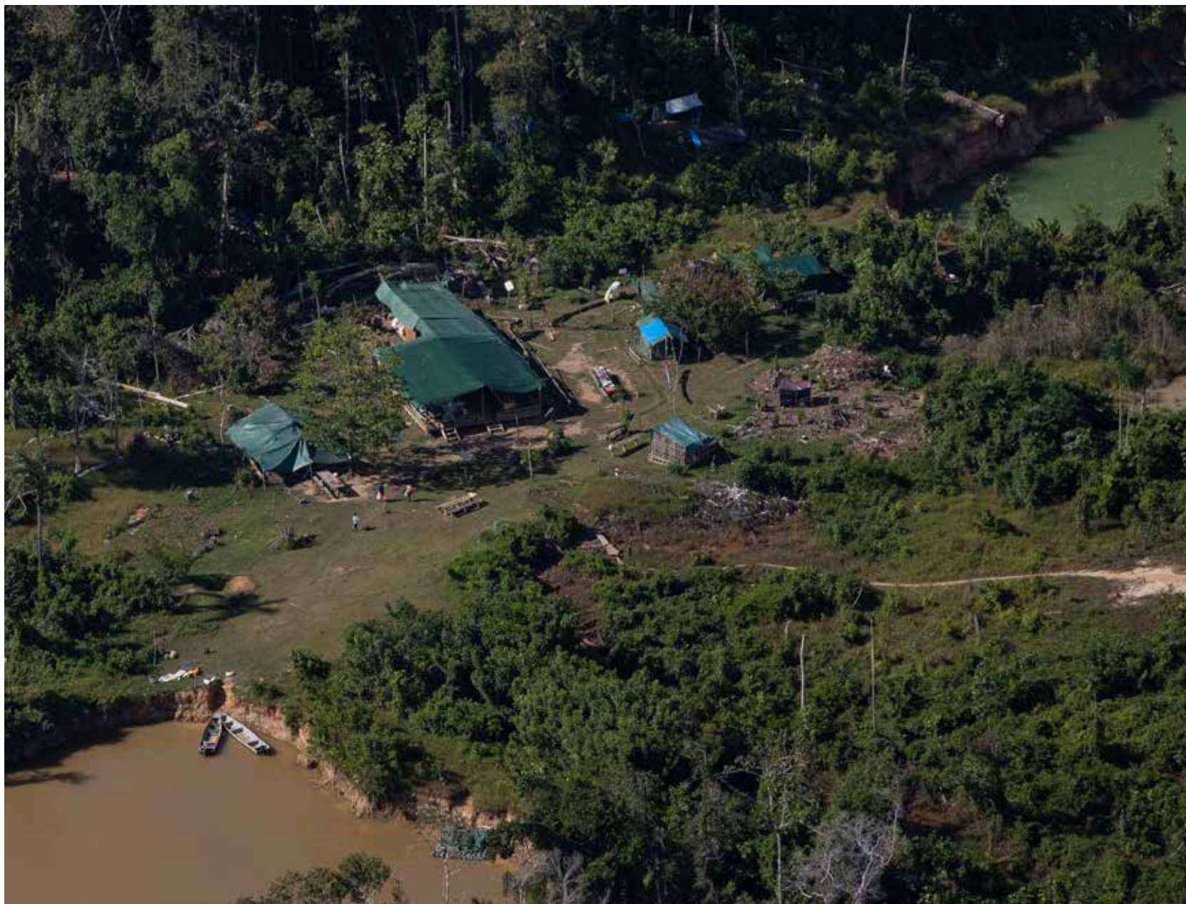
Foto 6: Estrutura que dá suporte à logística garimpeira no Uraricoera.
